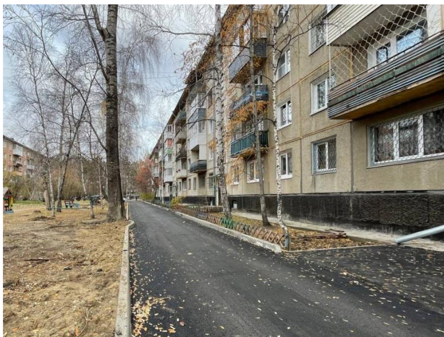
Рис. 5. Неблагоустроенная придомовая территория в г. Рубцовск.
