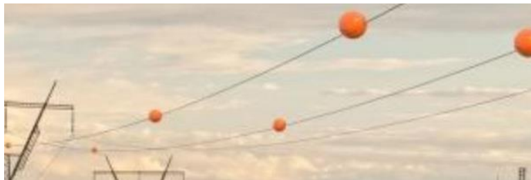
Рис. 3. Маркировка ЛЭП оранжевыми пластиковыми шарами
