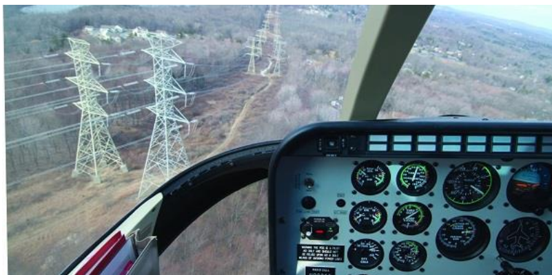
Рис. 1. Вид сверху на высоковольтные ЛЭП без маркировки
