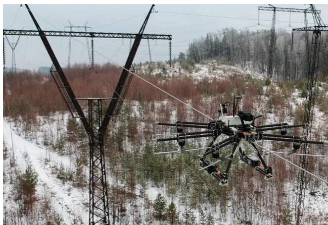
Рис. 2. «Канатоход» на пилотном обследовании выбранного участка ВЛ
