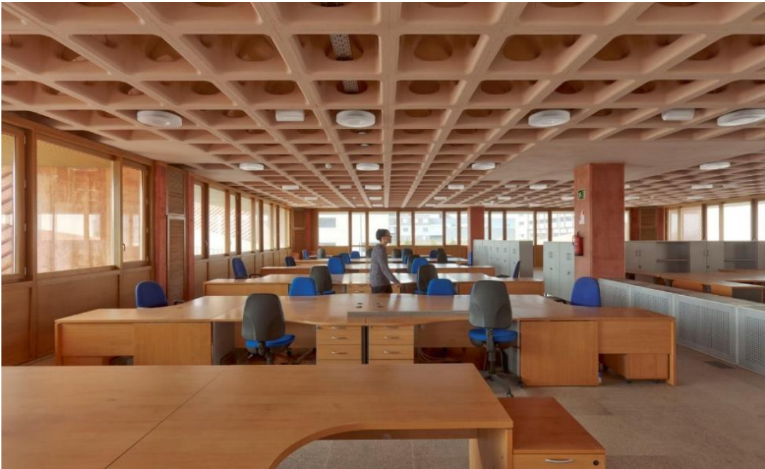
Рис.6. Общий вид внутри помещения здания Технологического университета в г. Алькала-де-Эрнарис, перекрытия по технологии «Holedeck».
