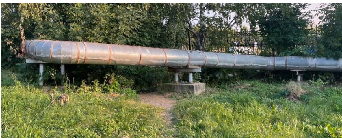
Рис.1. Надземное исполнение тепловой сети (а).
