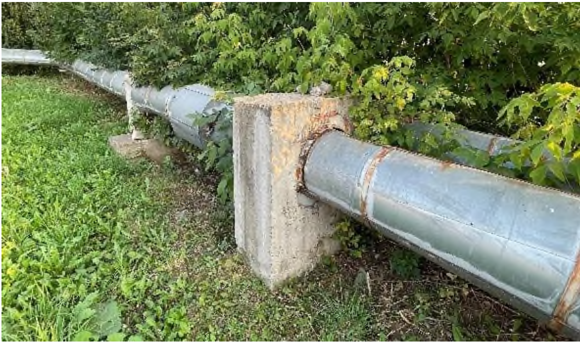
Рис.2. Надземное исполнение тепловой сети (б).
