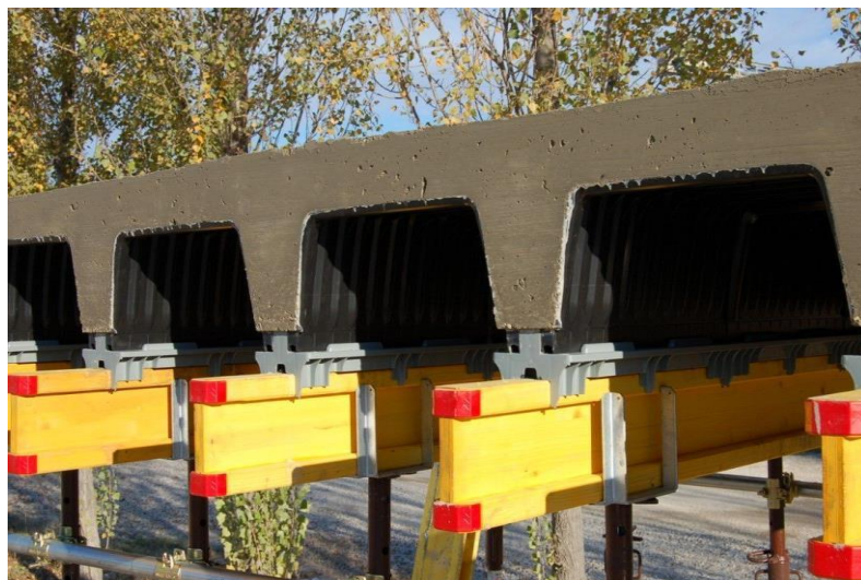
Рис. 4. Опалубочная система «Skyrail» в разрезе.
