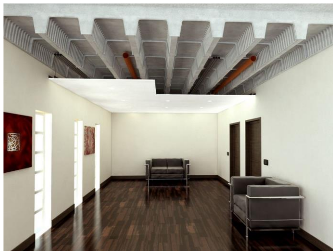
Рис.5. Общий вид однонаправленного облегченного перекрытия по опалубочной системе «Skyrail».
