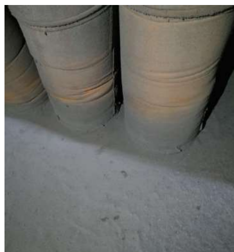
Рис. 5 – Нижнее крепление рукавов
