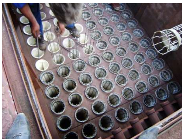
Рис. 11 – Одностороннее верхнее крепление рукавов
