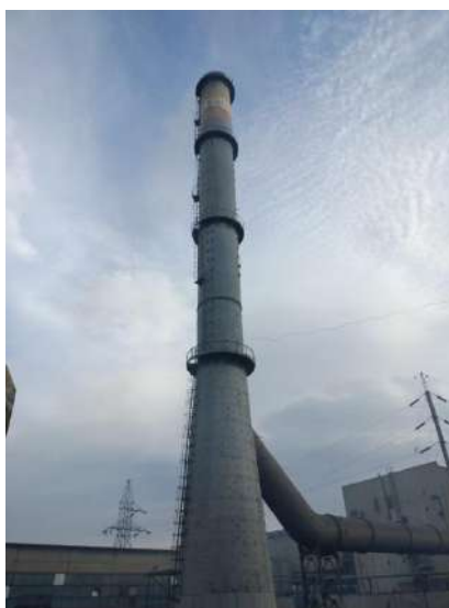
Рис. 12 – Дымовая труба для сосредоточенного выброса газов
